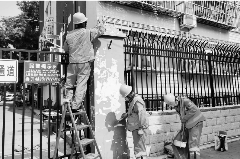
十字路口社区共建单位参与墙面立柱修葺
