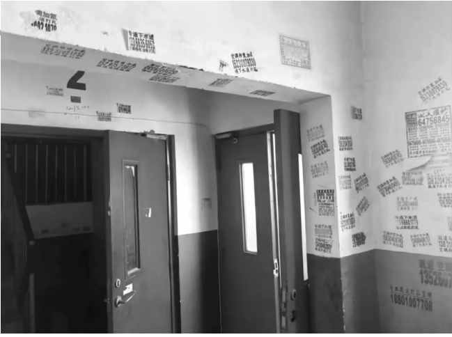
尚家楼48号院整治前
