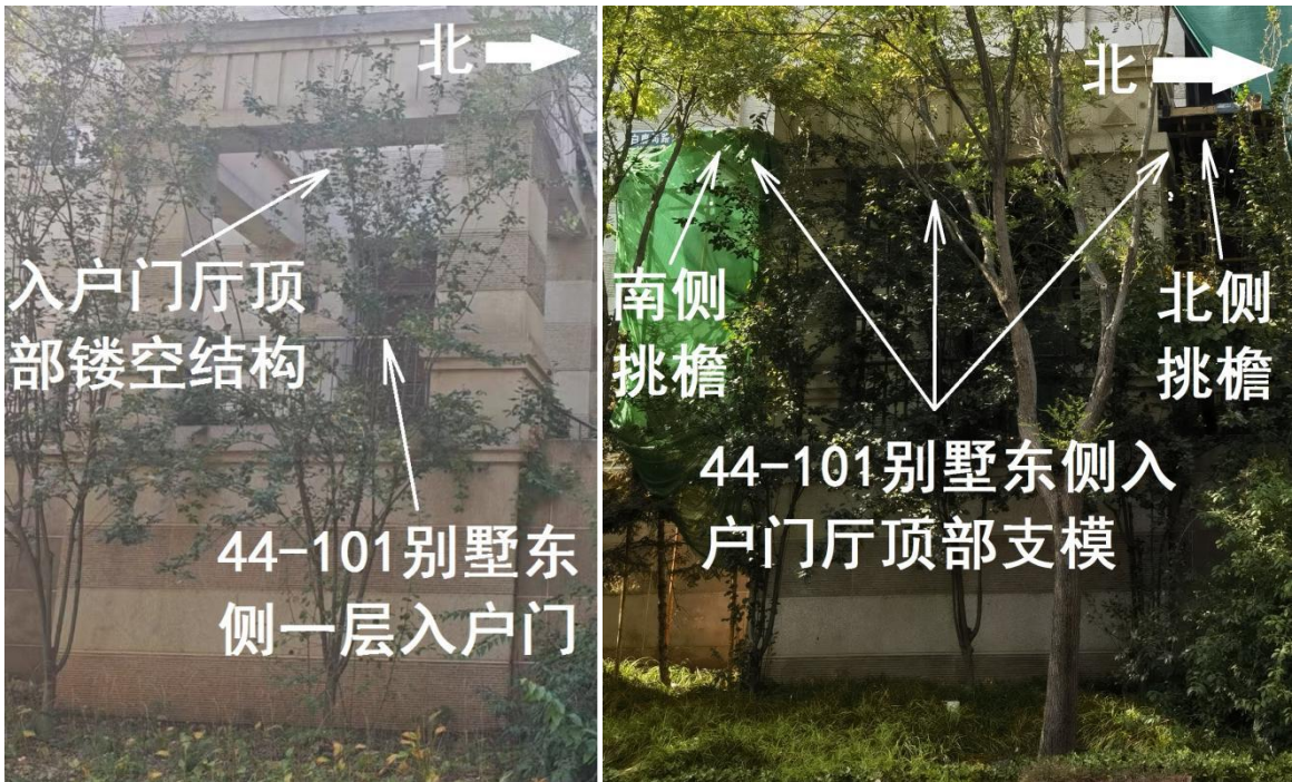
图 1 涉事别墅东侧入户门厅原貌 图 2 东侧入户门厅改造情况
