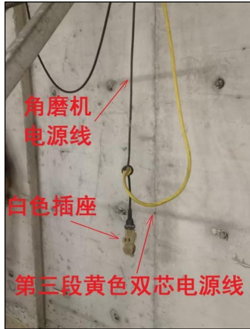
图8 第三段黄色电源线与 角磨机插头连接处
