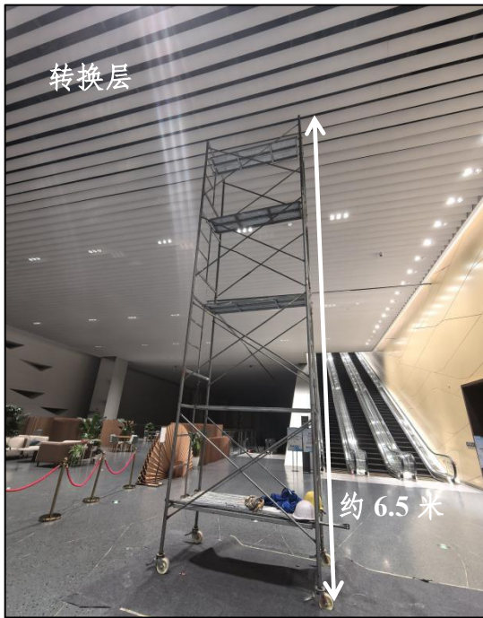
图 3 作业使用的脚手架
